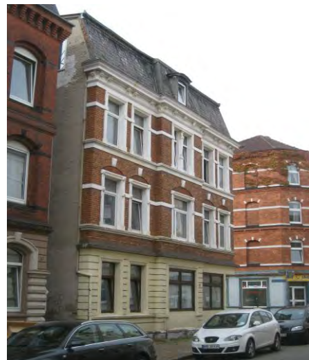
2 Geschosswohnungsbau der Gründerzeit
