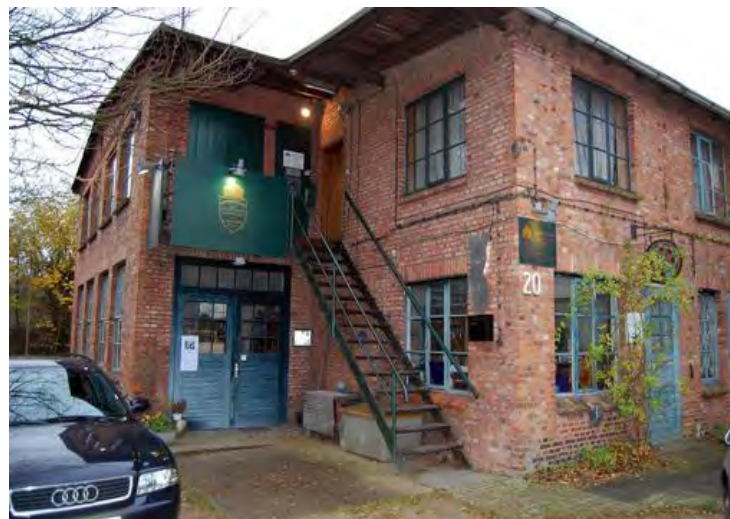
12 Kulturdenkmal Hintergebäude Esplanade 20
